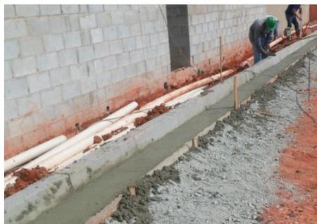
Imagem: Exemplo de execução de sarjeta moldada in-loco
